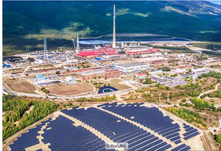
Aurubis Pirdop mit Solarpark
